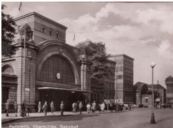
DER BAHNHOF NACH DEM UMBAU VON 1906 DWORZEC PO ROZBUDOWIE W ROKU 1906
